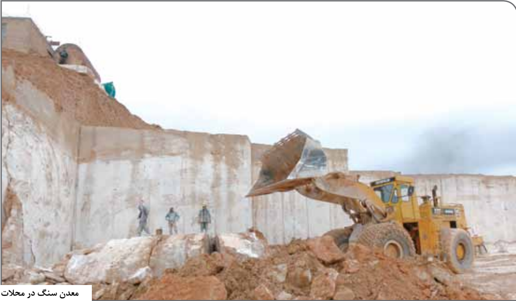
تجهیز کارگاه معدن سنگ در محلات
