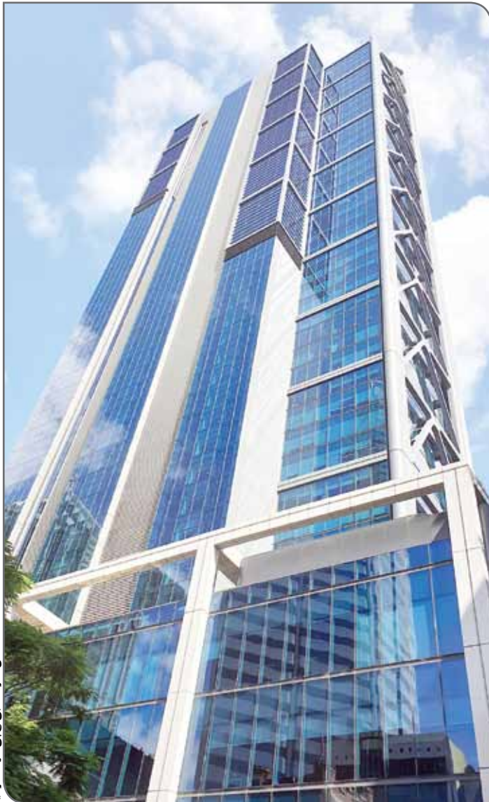
ساختمان شرکت چای‌تی در استرالیا
